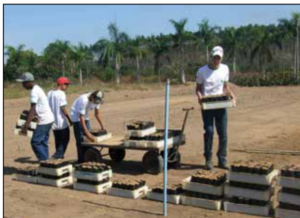
Transportando as sacolas para o local onde serão construídos os canteiros
