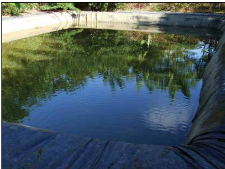
Tanque de 500 mil litros na Fundação Bionativa para armazenamento de água
