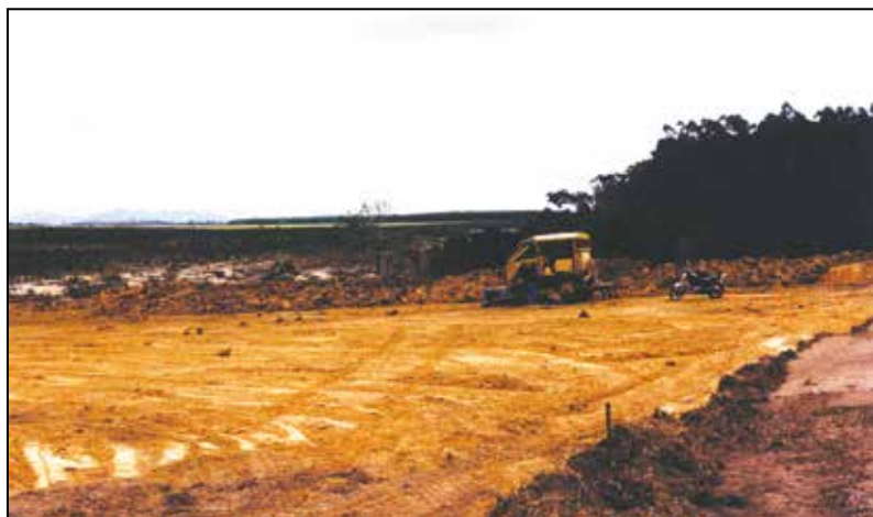
Terraplanagem realizada com ajuda de veículos [trator e cavadeira] para construção de um viveiro. Pode-se observar que a camada superficial do solo é retirada
