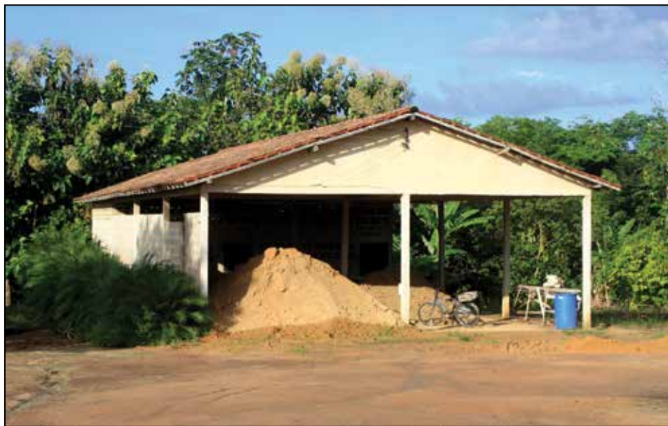
Galpão da Bionativa. Duas das paredes são abertas para ter circulação de ar e evitar que o local fique empoeirado ao se trabalhar com o substrato para produção de mudas
