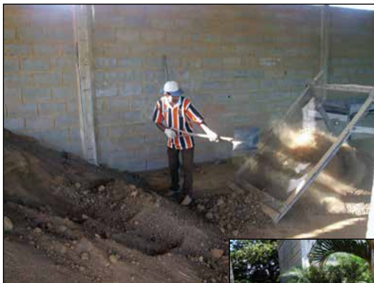
Peneirando o substrato (barro). Observe que a peneira é feita de materiais facilmente acessíveis como ripas de madeira
