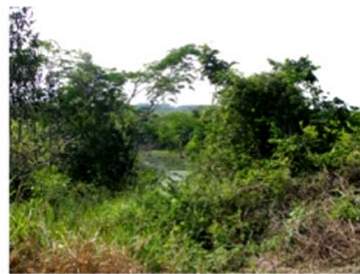
Vista da barragem da Fazenda Pampulha a partir da nascente do Córrego Chumbado.
