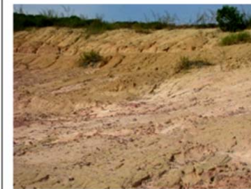
Margem direita da barragem próxima do final da propriedade: área com ausência de cobertura vegetal.
