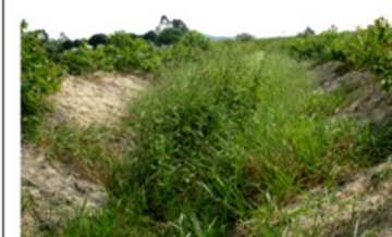
Vala construída para drenagem de água de chuva.
